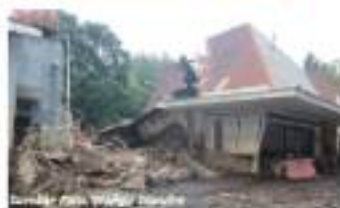
Gambar 3.3. Dampak Banjir Bandang di Kab. Tanah Datar
